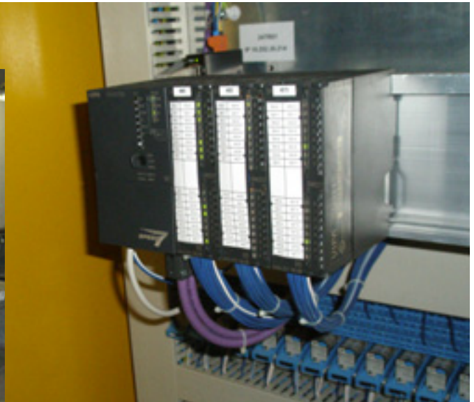
Die schnellen SPS der Serie 315 SN von Vipa sorgen für den zuverlässigen Materiefluss im Universitätsspital Basel. (Bilder: Feurstein)
